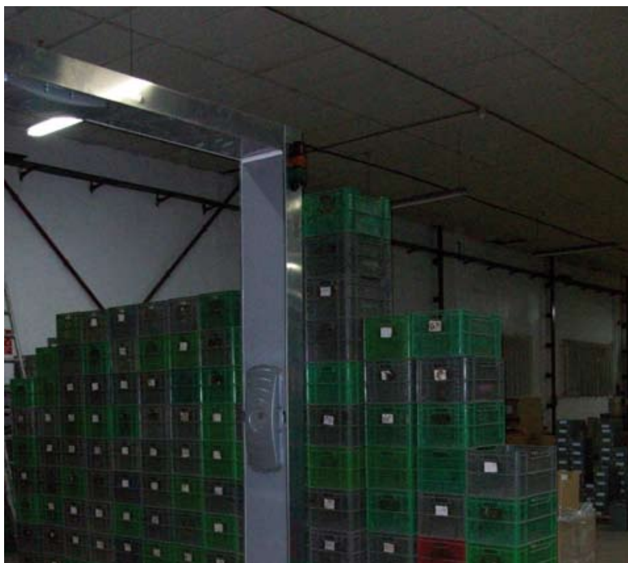
Portal lector RFID situado entre el almacén y control de calidad
